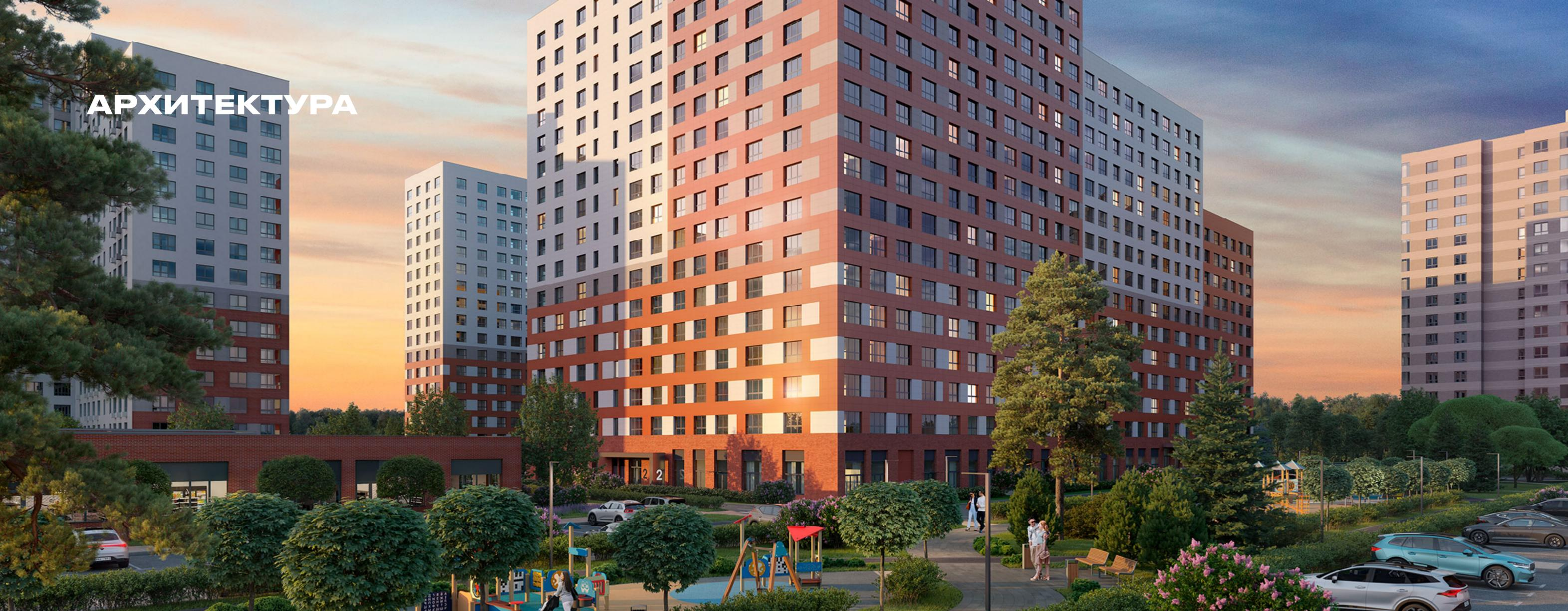
Все дома построены по монолитной технологии с использованием энергоэффективных экологически чистых материалов. Фасады корпусов новой очереди выполнены из керамогранита по системе с облицовкой первого этажа керамическим кирпичом.
